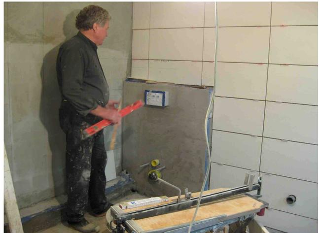
Einbau der Vorwandinstallation für die wandhängenden Toiletten
