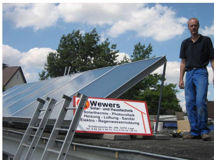
Diese jetzt auf dem Dach des Freibadgebäudes montierten 6 Solarzellen sammeln ab sofort die notwendige Energie zur Aufheizung des Duschwassers im Freibad Heiden.
