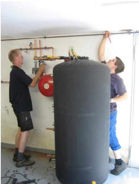
Ein hochwertiger, innen emailierter Tank-in-Tank TERMO Kombispeicher der Fa. Wagner mit 700 Liter Inhalt speichert die auf dem Dach eingefangene Wärme im Keller des Freibadgebäudes.
